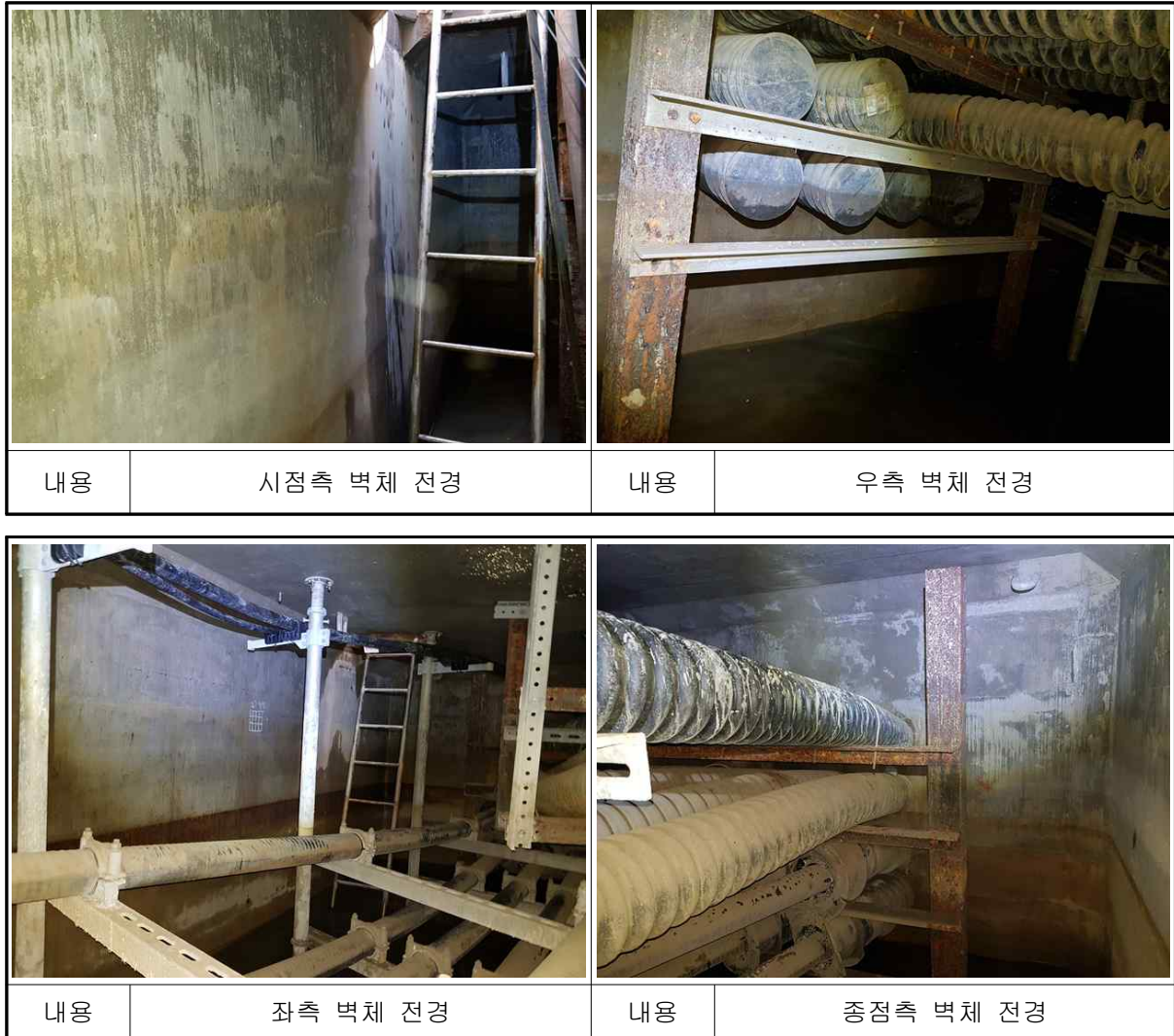
【사진 3.5】 문발~운정 #7-1 전경
