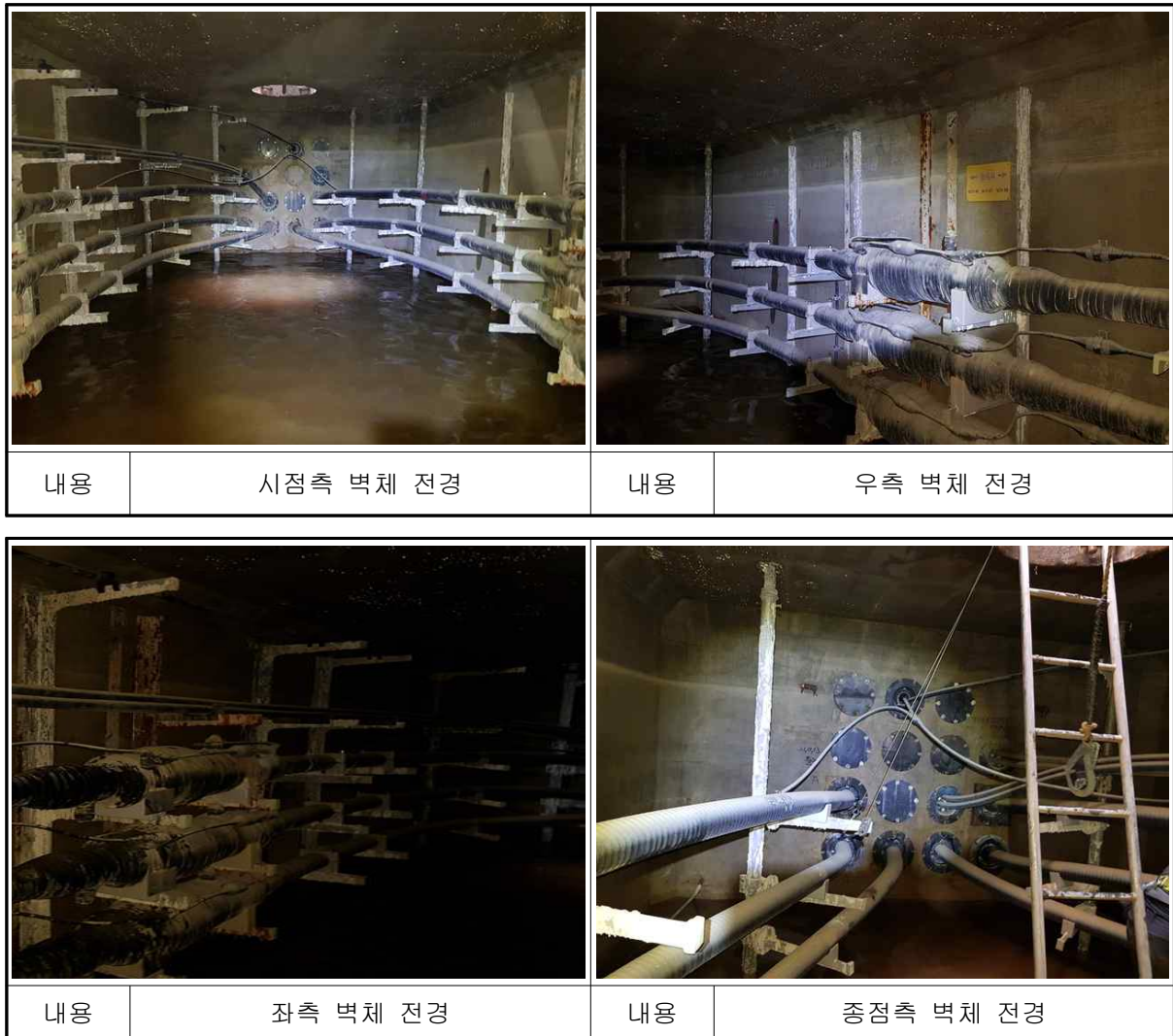
【사진 3.1】 문발~운정 #7 전경
